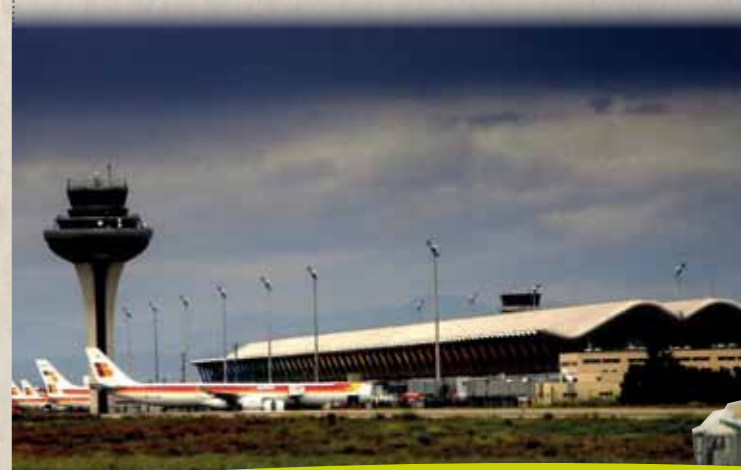
T-4 - Aeropuerto . Barajas (Madrid)
